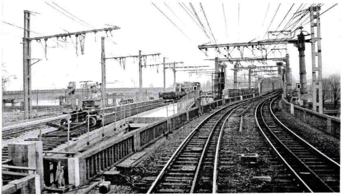
De haut en bas : Nouveau viaduc ferroviaire de BORDEAUX : 07 février 2008 : vue générale depuis la rive gauche de la partie sur le fleuve. 18 février : vue du viaduc et de la "passerelle". Remarquer l'inflexion provisoire vers la gauche des voies du nouvel ouvrage. 21 février : situation des quatre voies, deux en service sur la "passerelle" et les deux en travaux sur le nouveau pont. Photos ABAC.
