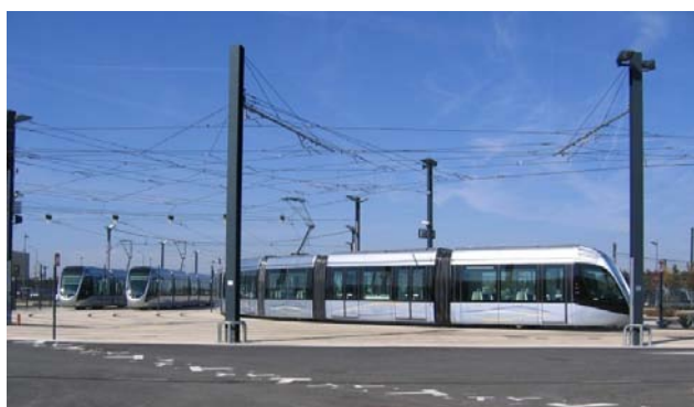
Garage des rames
