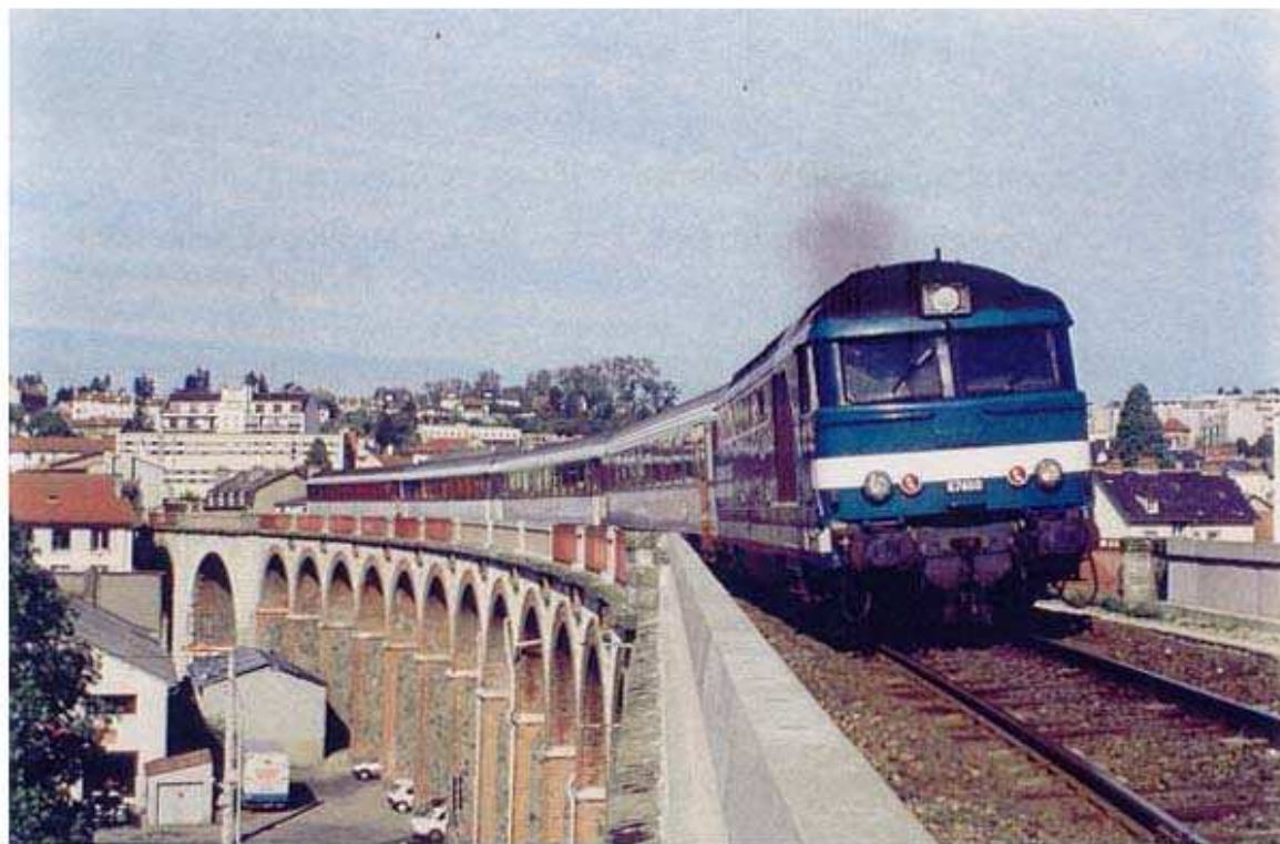
L'Express 5962 Aurillac – Paris gare de Lyon sur le viaduc d'Aurillac 25 septembre 1994
