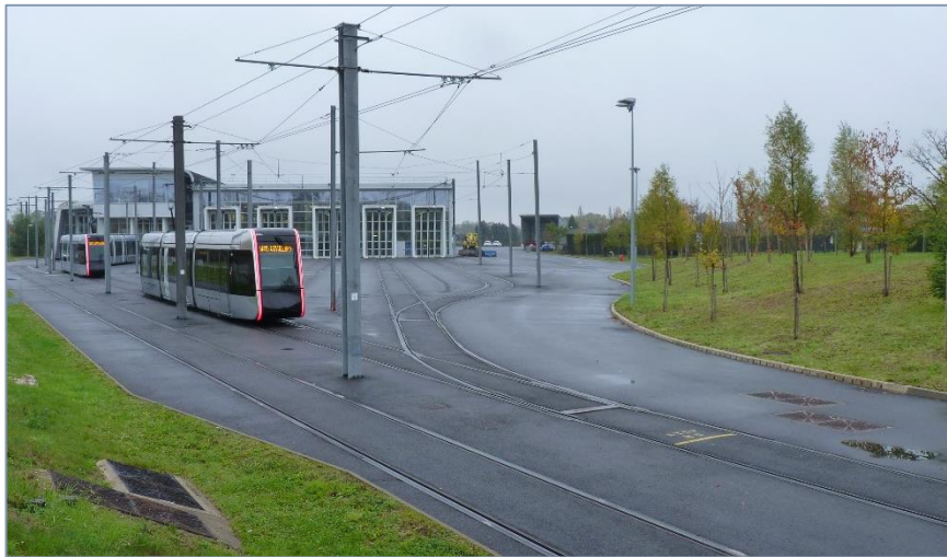
Vue générale du Centre de Maintenance, avec le secteur rentrée des rames. Au fond, l'atelier ; le PCC se trouve dans la partie supérieure du bâtiment, à gauche.
