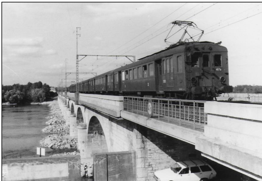
Le train 7028 Tours – Blois franchit le viaduc de Montlouis, avec la Z 4172 en queue de convoi. La Route nationale est visible au premier plan. 14 août 1982.
