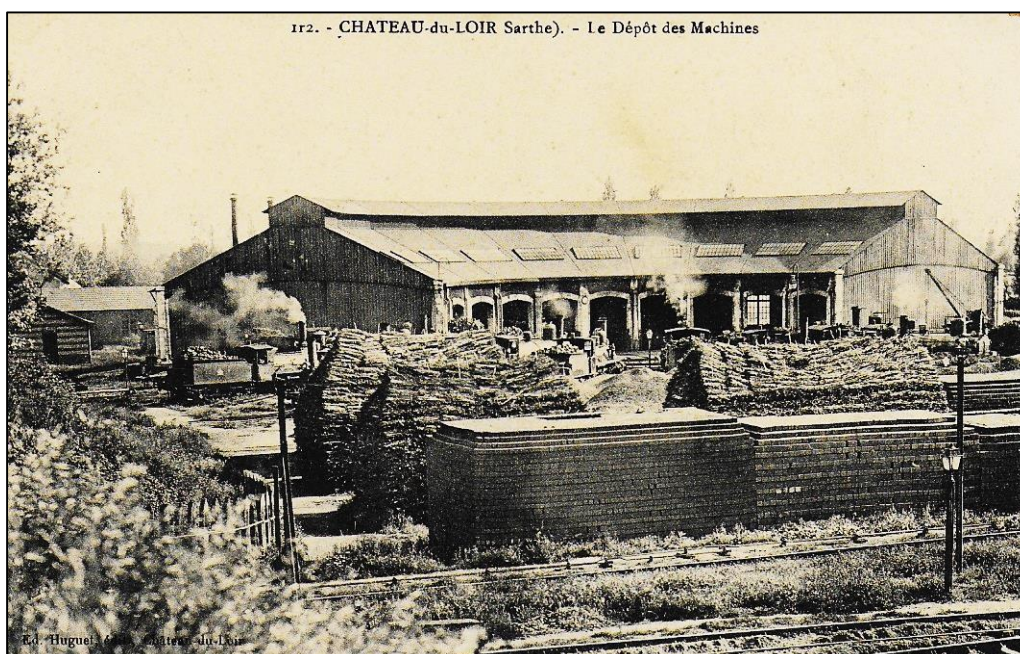
Le dépôt de Château-du-Loir du temps de l'Etat. Le bâtiment a peu changé depuis, mais les verrières en toiture ont disparu.
