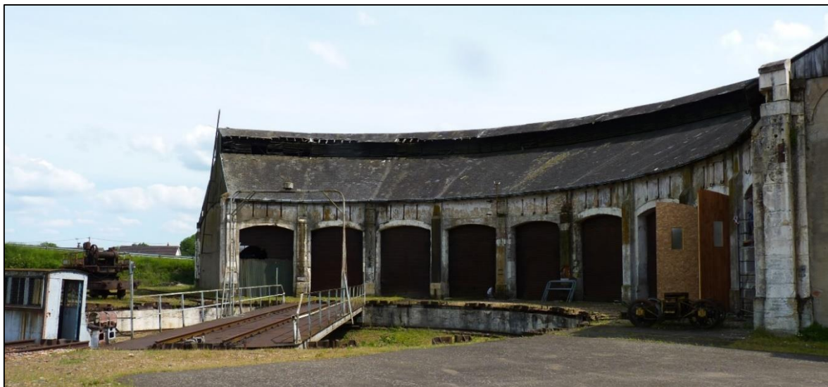
La rotonde de l'ancien dépôt de Château-du-Loir, telle qu'elle se présente aujourd'hui
