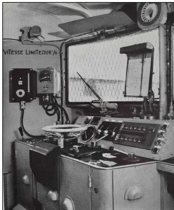
Intérieur de la cabine de la BB 9291 On distingue à gauche de l’indicateur de vitesse le boîtier de signalisation en cabine Photo SNCF – collection AFAC
